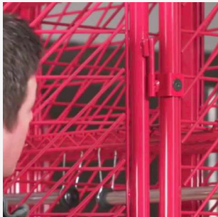
INSTALL THE DOOR
